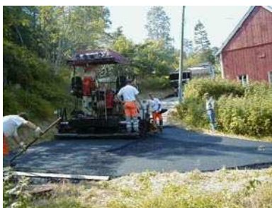
Asfaltarbejde i Norge
